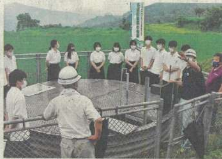
地すべり対策として設置された集水井を見学する生徒ら。香美町村岡区板仕野。
