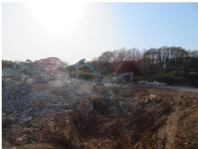
体育館の跡は深くまで掘り起こされていました。
