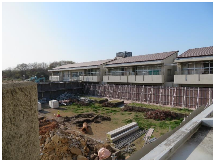
中庭もすっかり工事の材料置き場に
