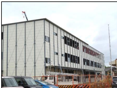
8月20日 外観は完成間近
