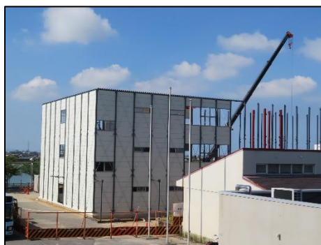
8月1日 東側の外壁がほぼ完成
