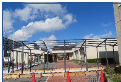
F棟とA棟を結ぶ渡り廊下、給食室までの動線確保
