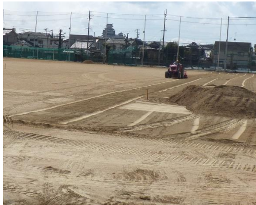
新しい土をいれ、GR工法で整地し勾配修正をしました
