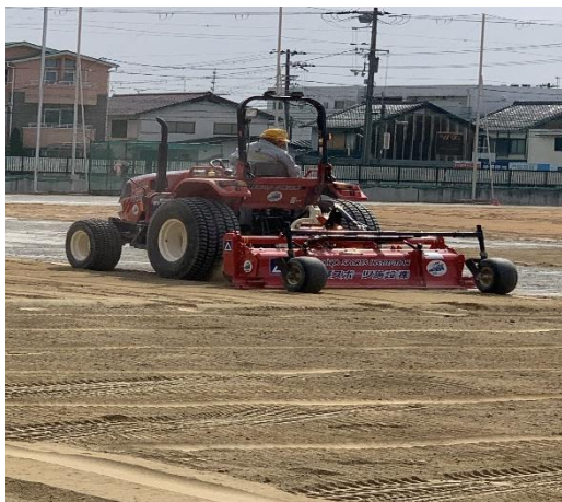
新しい土をいれ、GR工法で整地し勾配修正をしました
