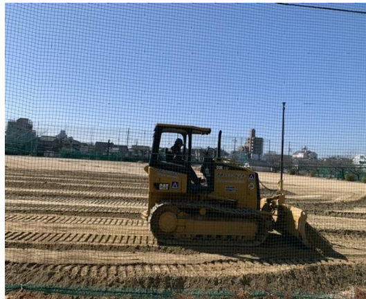
新しい土をいれ、GR工法で整地し勾配修正をしました
