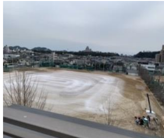
新しい土をいれ、GR工法で整地し勾配修正をしました
